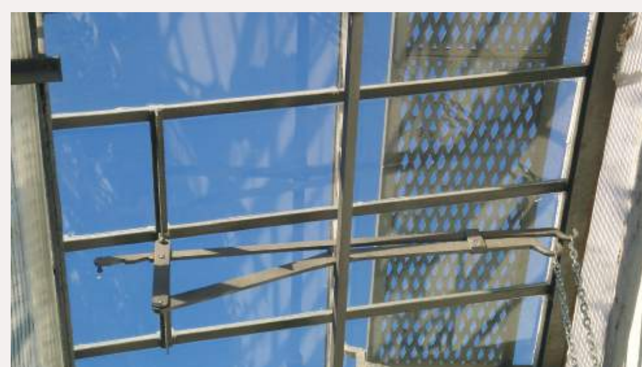
Vivero de Estufas: sistema de aireación cenital de la estufa nº 7.
