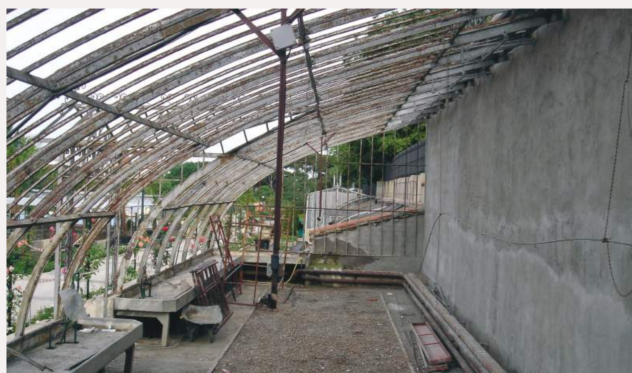
Vivero de Estufas: aspecto del interior de la nave lateral de la estufa nº 7 durante su última restauración.
