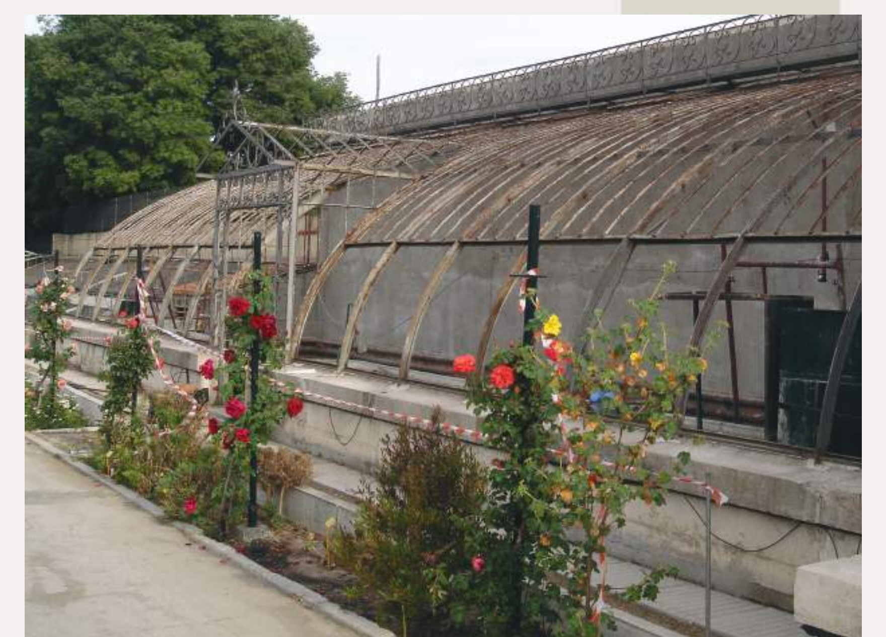
Vivero de Estufas: el exterior de la nave lateral de la estufa nº 7 durante su última restauración.
